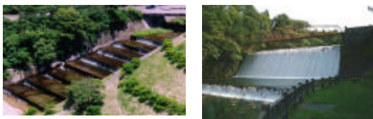
図 2.1 システムとして保全される用水 (左:本庄水源の工事中にできた付け替え河川の石段 右:藤倉ダム)
